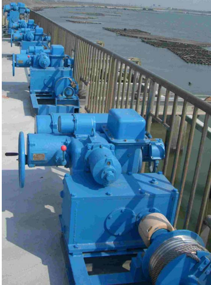
說明：朴子溪東石堤防水門
